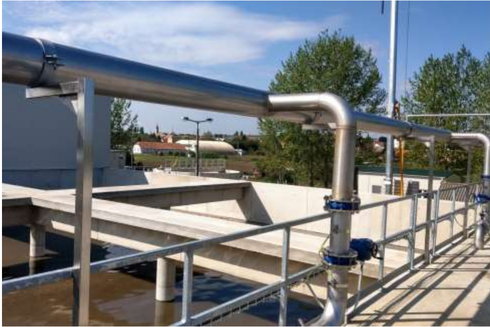
Bonyhádi Szennyvíztisztító Telep rekonstrukció (2020. április 30.)
